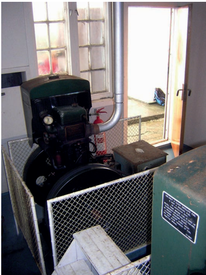
Fra maskinrommet, foto fra 2005.
