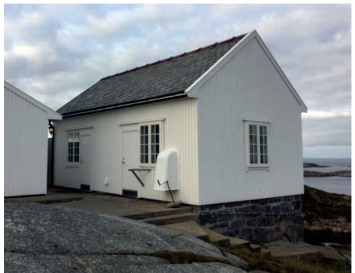
Fasadehjørne mot sydøst.
