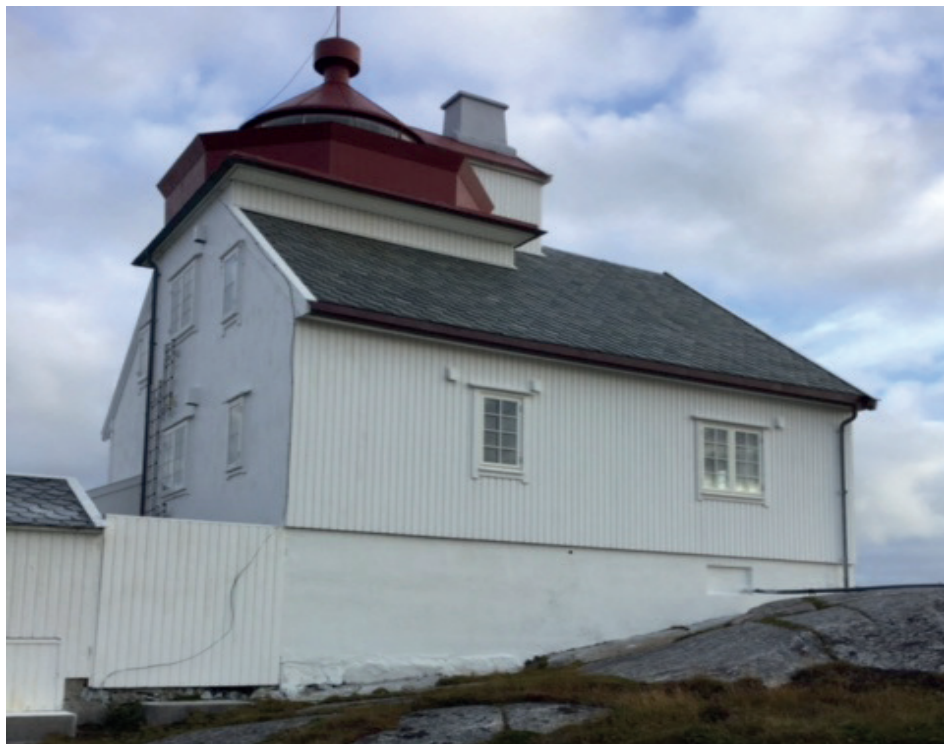
Fasadehjørne mot nordvest
